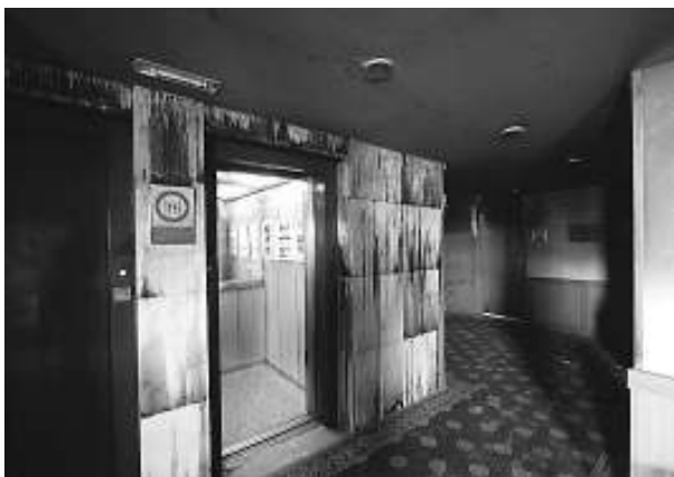
L'ascensor fumat, a la quarta planta. / LLUÍS SERRAT
